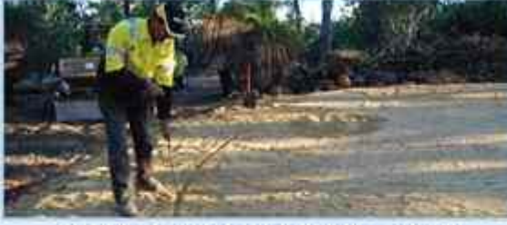
Tank yarı çapının işaretlenmesi
