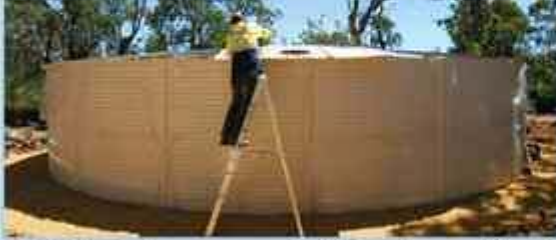
Çatı tabakalarının mertek üzerine serilmesi ve montajı
