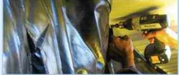
Esnek membranın montaj ve sağlamlaştırılması
