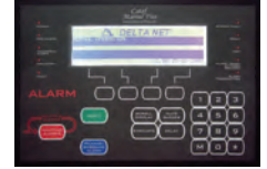
Yangın Tespit Sistemi Paneli
