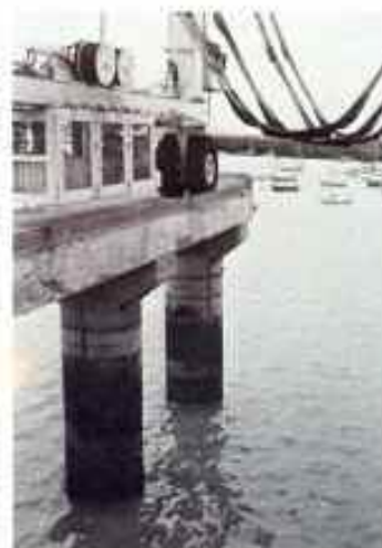
1. E100 - Chambre de Commerce et d'Industrie - Granville (France)
